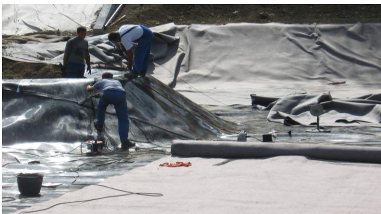
Slika 7: Polaganje PEHD folije (Komunala Nova Gorica, 2009b)
