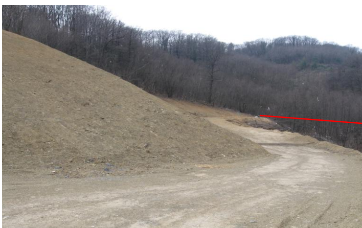
Slika 6: Azbestni odpadki, prekriti z zemljo
