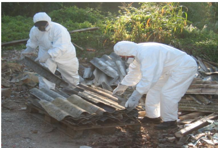
Slika 9: Zaščiteni delavca pri zlaganju azbest cementnih plošč na paleto.
