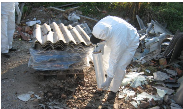
Slika 10: Ovijanje azbest cementne kritine
