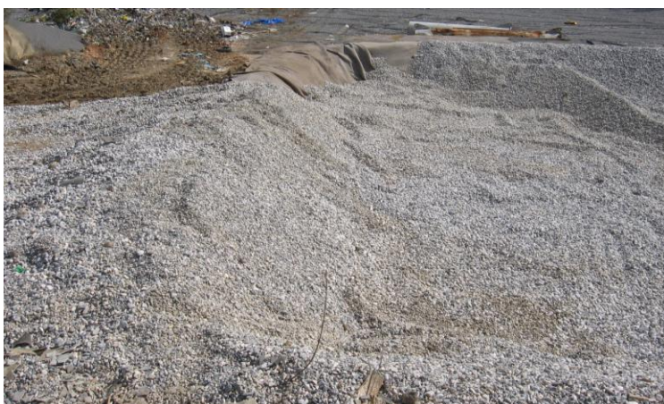
Slika 8: Urejanje dna odlagališča za azbestne odpadke (Komunala Nova Gorica, 2009b)
